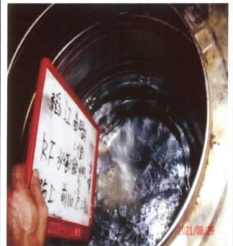
川堂 4F 頂樓水塔-3 施工前
