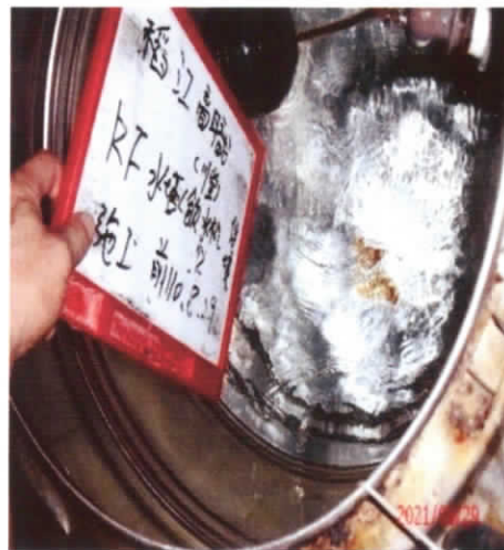
川堂 4F 頂樓水塔-2 施工前
