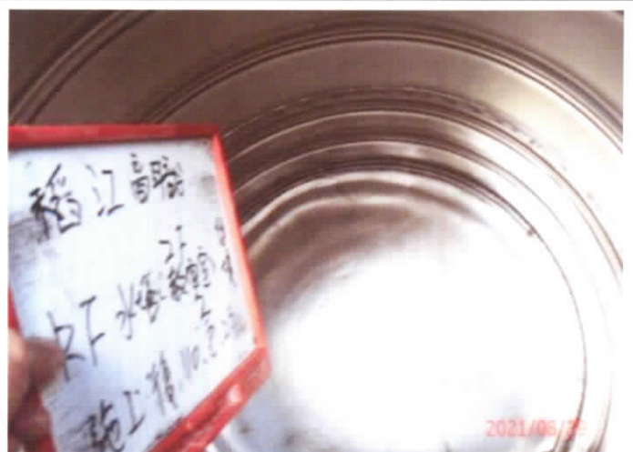
教官室 2F 頂樓水塔-2 施工後
