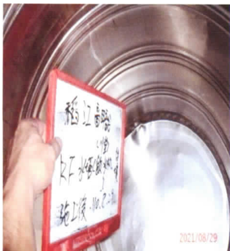
川堂 4F 頂樓水塔-1 施工後
