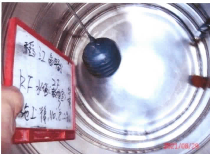
教官室 2F 頂樓水塔-1 施工後
