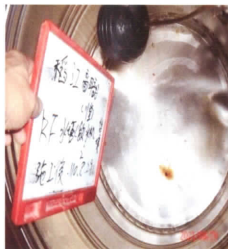
川堂 4F 頂樓水塔-2 施工後
