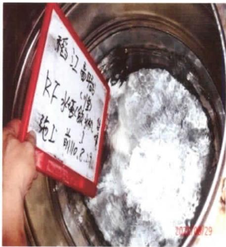
川堂 4F 頂樓水塔-1 施工前
