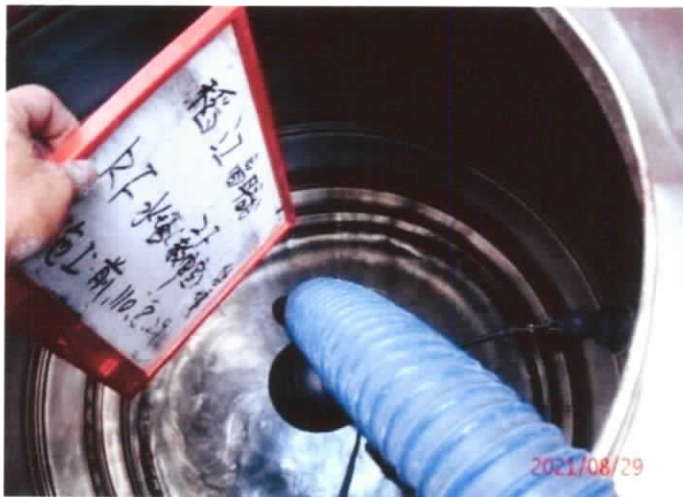
教官室 2F 頂樓水塔-1 施工前
