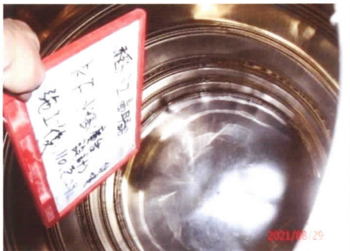
廣告設計頂樓水塔 施工後
