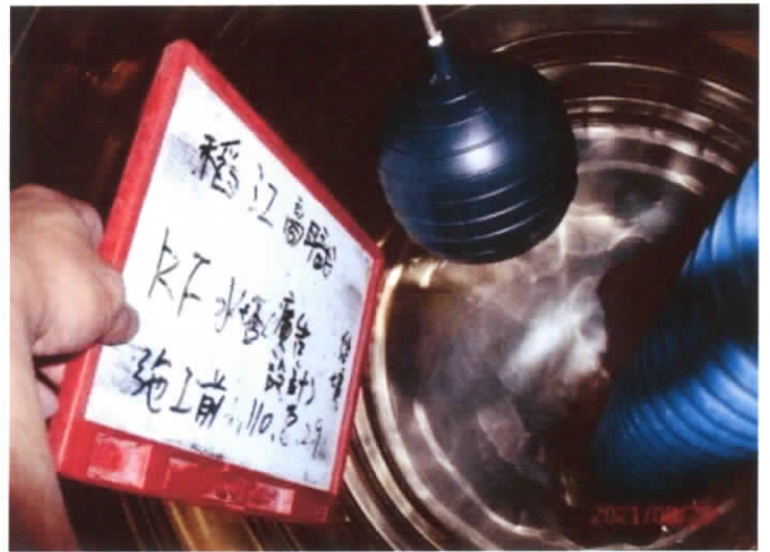
廣告設計頂樓水塔 施工前
