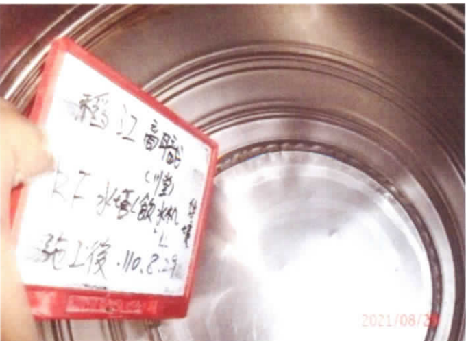
川堂 4F 頂樓水塔-4 施工後
