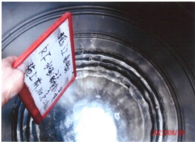
教官室 2F 頂樓水塔-3 施工前
