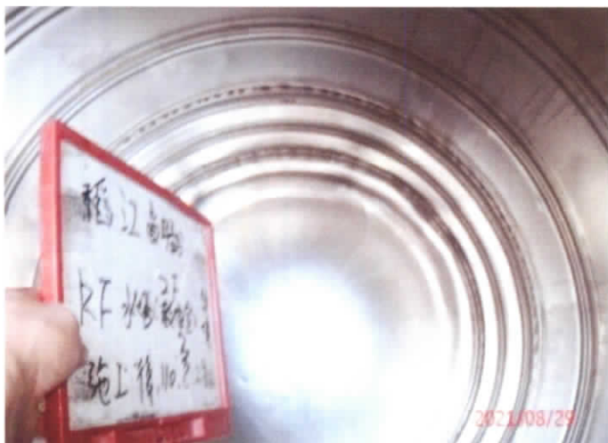
教官室 2F 頂樓水塔-3 施工後
